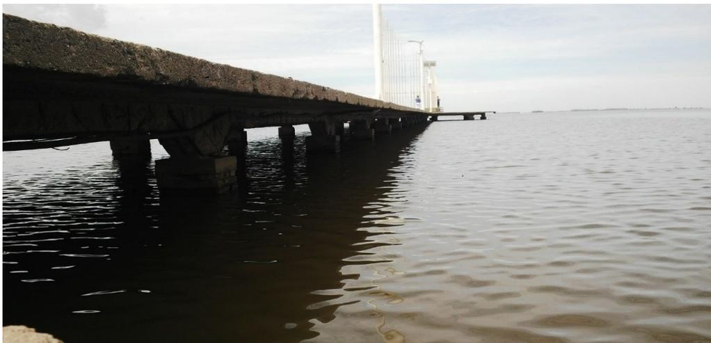
Foto Nº 2 – Vista inferior del espigón. Losa, viga, y capitel con pérdida de recubrimiento y armaduras expuestas.
